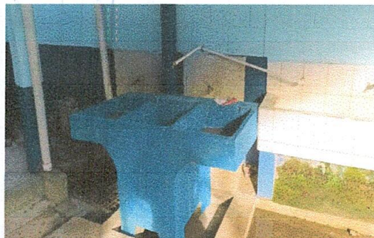
Foto 2: Sustitución de pila de cemento de dos lavaderos
