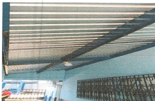
Foto 4: Sustitución de lámparas tipo LED
