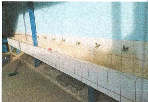
Foto1: Sustitución de chorro
