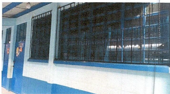
Foto 3: Mejoramiento de balcones de metal
