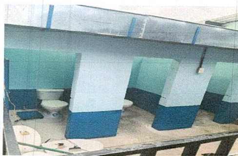
Foto 6: Sustitución de inodoros y sus accesorios
