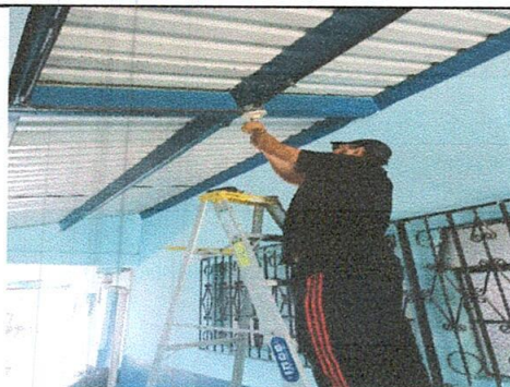
Foto 4: Sustitución de lámparas tipo LED
