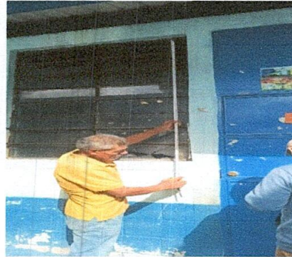
Foto 2: Sustitución de vidrios de 24 centímetros de alto por 45 centímetros de ancho
