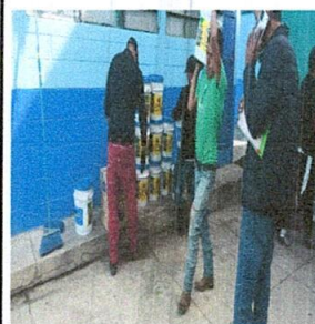
Foto 4: Pintura de muros exteriores e interiores
