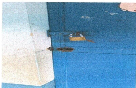
Foto 3: Sustitución de chapa
