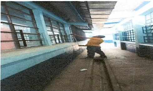
Foto 3: Mejoramiento de balcones de metal
