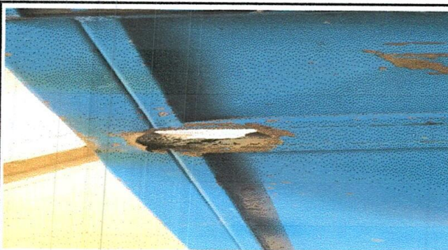
Foto 4: Sustitución de chapa
