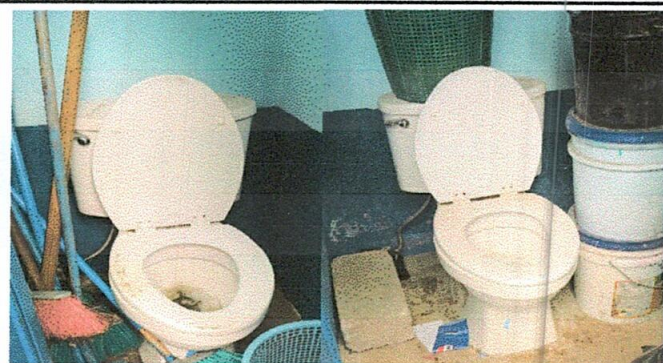
Foto1: Sustitución de inodoros y sus accesorios
