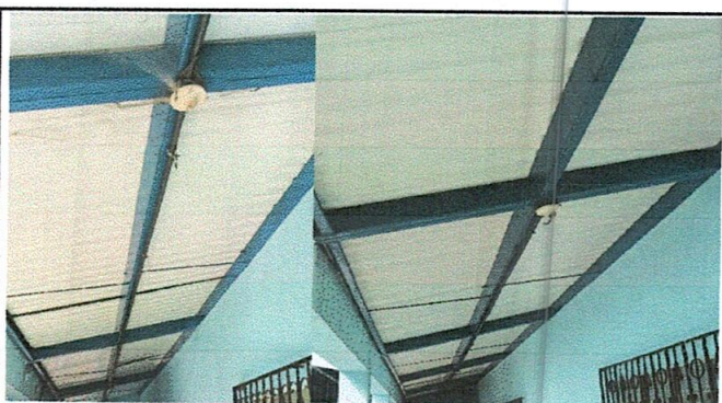
Foto 5: Sustitución de lámparas tipo LED
