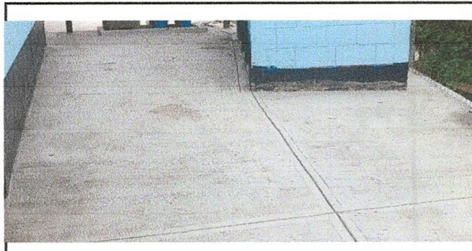
Foto 6: LOSA DE PATIO
