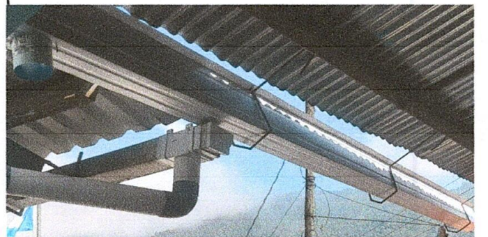
Foto 4: CANALES Y BAJADAS DE AGUA PLUVIAL
