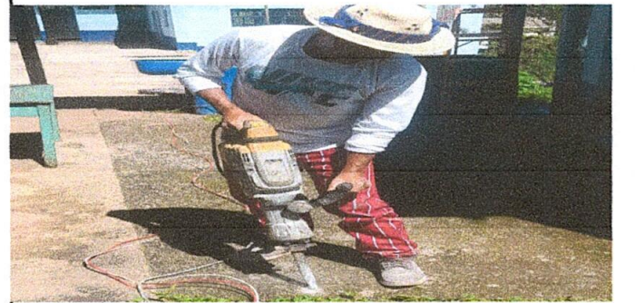
Foto 6: LOSA DE PATIO
