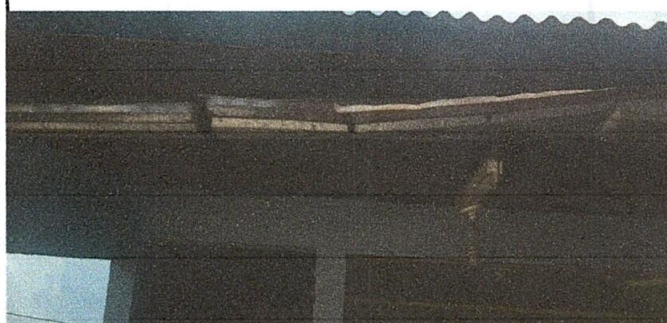
Foto 4: CANALES Y BAJADAS DE AGUA PLUVIAL
