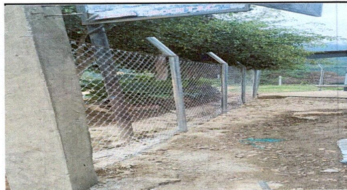
Foto 4: Sustrucción de muro perimetral de tubo hg y malla galvanizada
