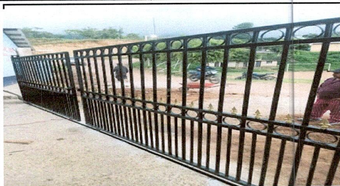
Foto 1: Sustrucción de puerta de tubo galvanizado y malla abatimiento doble de 1.00 metro de ancho por 2.10 metros de alto
