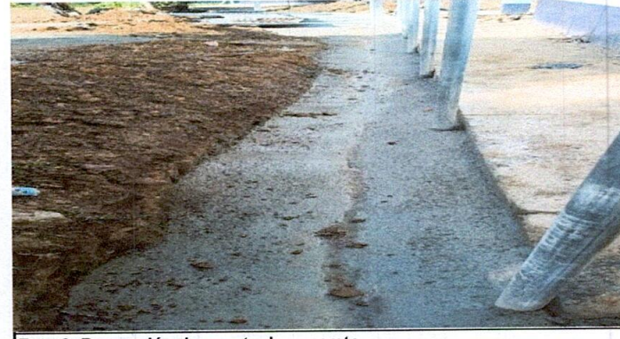
Foto 6: Reparación de cuneta de concreto
