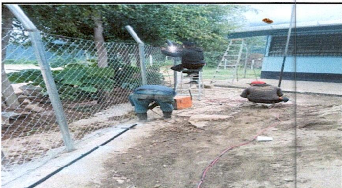
Foto 3: Sustitución de muro perimetral de tubo hg y malla galvanizada
