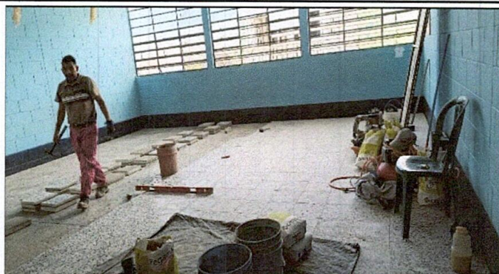
Foto 2: Sustitucion de piso de torta de cemento por piso granito
