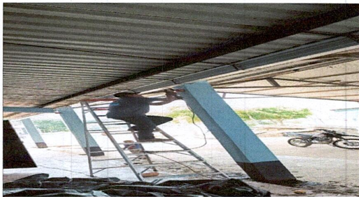
Foto 4: Sustitución de canal de metal
