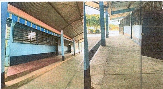
Foto 3: Sustitución de piso de torta de cemento por piso granito
