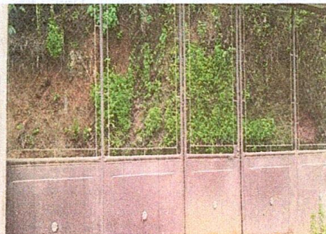
Foto 2: Sustitución de portón de tubo galvanizado y malla abatimiento doble de 5.00 metros de ancho por 2.10 metros de alto
