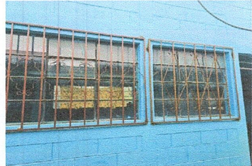
Foto 2: Mejoramiento de balcones de metal
