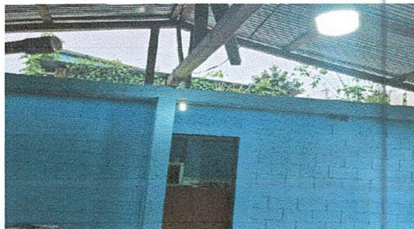
Foto1: REPARACION DE SISTEMA ELECTRICO
