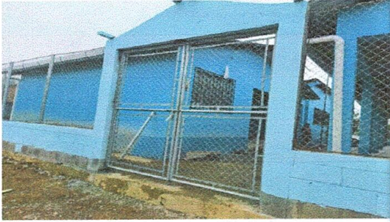
Foto 1: Puerta de tubo galvanizado y malla abatimiento doble de 2.00 metros de ancho por 1.50 metros de alto
