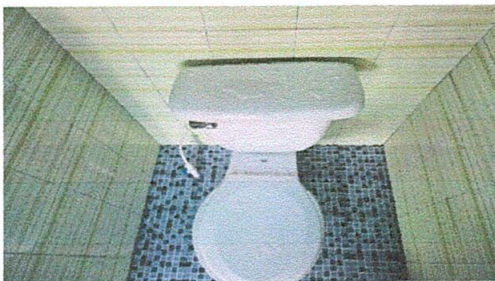
Foto 5: Sustitución de tapaderas para sanitarios
