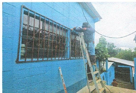
Foto 2: Mejoramiento de balcones de metal
