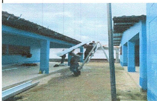
Foto 4: Mejoramiento de canal de metal
