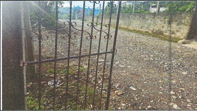
Foto 1: Sustrucción de puerta de tubo galvanizado y malla abatimiento doble de 2.00 metros de ancho por 1.50 metros de alto
