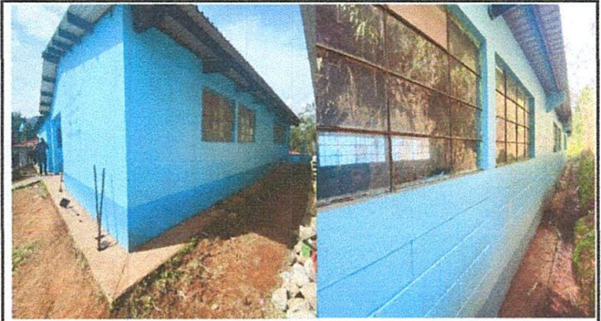
Foto 2: Mejoramiento de balcones de metal
