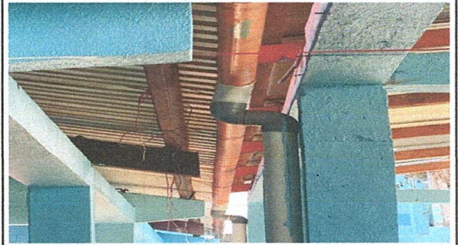
Foto 4: Mejoramiento de canal de metal
