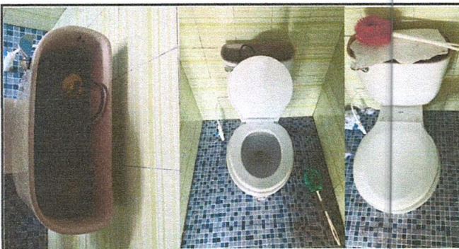
Foto 5: Sustrucción de tapaderas para sanitarios
