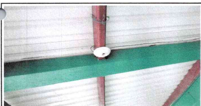
SUSTITUCIÓN DE FOCOS AHORRADORES
