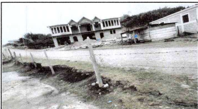
SUSTITUCIÓN DE MURO PERIMETRAL
