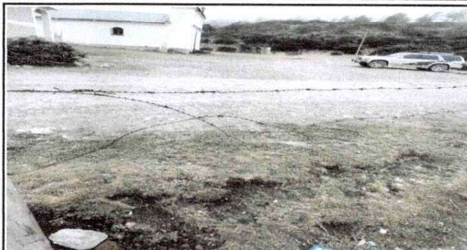
SUSTITUCIÓN DE MURO PERIMETRAL
