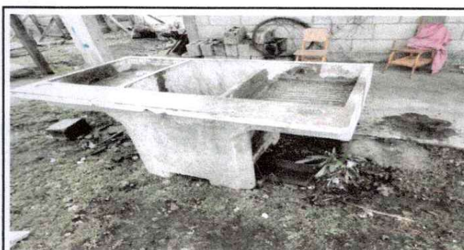
SUSTITUCIÓN DE PILA
