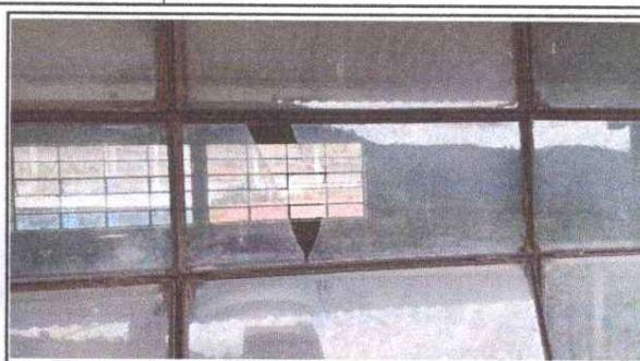
FOTO 2: SUSTITUCIÓN DE BALCONES
