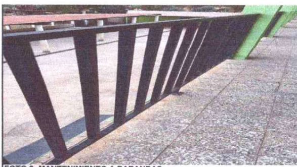
FOTO 6: MANTENIMIENTO A BARANDAS
