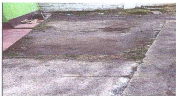
FOTO 3: REPARACION DE LOSA DE PATIO
