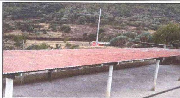
FOTO 1: SUSTITUCION DE LAMINA
