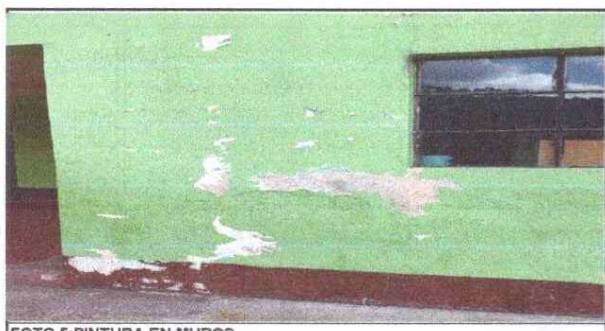
FOTO 5: PINTURA EN MUROS
