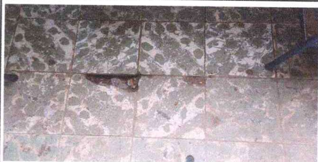
SUSTITUCION DE PISO GRANITO
