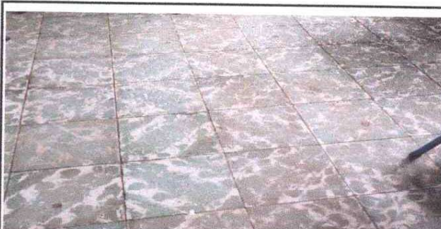
SUSTITUCION DE PISO GRANITO
