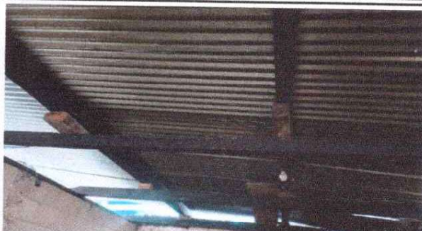
SUSTITUCION DE ESTRUCTURA DE TECHO
