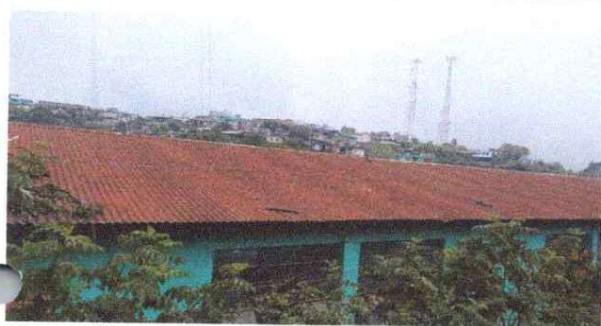
SUSTITUCION DE LAMINA
