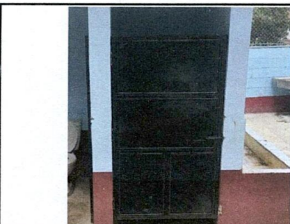
Foto 5: Sustitución de puerta en servicios sanitarios
