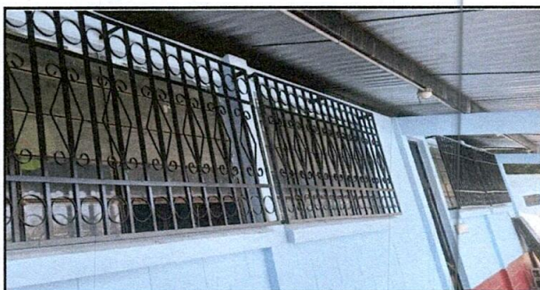
Foto 11: Mejoramiento de balcones de metal
