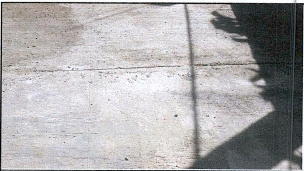
Foto 3: Mejoramiento de piso de concreto
