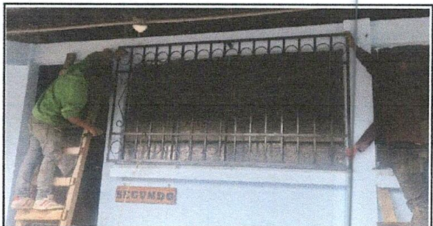
Foto 11: Mejoramiento de balcones de metal
