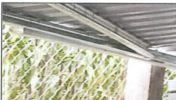
Foto 10: Mejoramiento de canal de pvc
