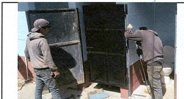
Foto 5: Sustitución de puerta en servicios sanitarios
