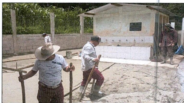
Foto 3: Mejoramiento de piso de concreto
