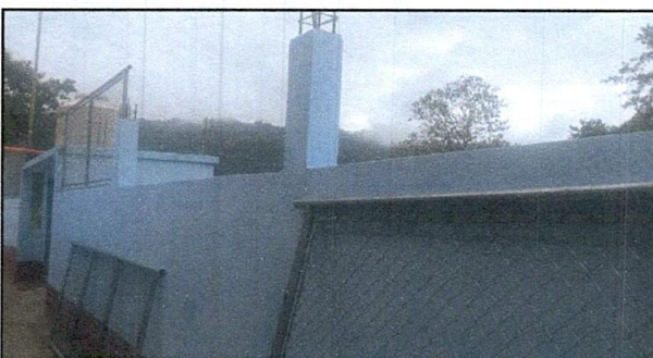
Foto 6: Mejoramiento de tubo galvanizado y malla galvanizada
