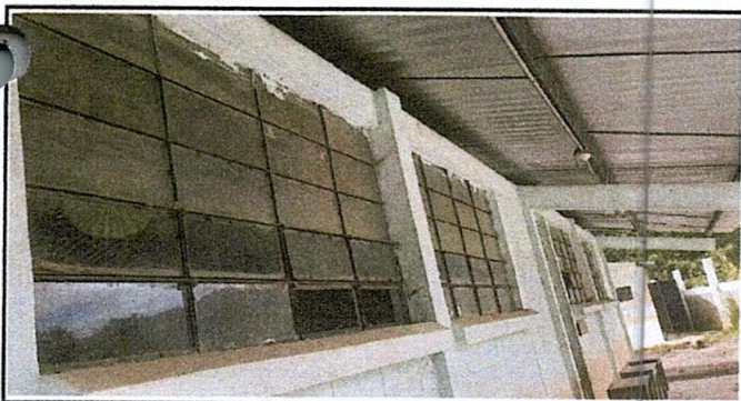
Foto 11: Mejoramiento de balcones de metal
