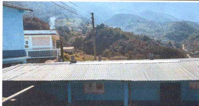
SUSTITUCION DE LAMINA
