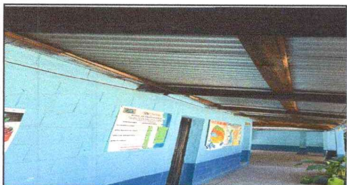
SUSTITUCIÓN DE ESTRUCTURA DE TECHO
