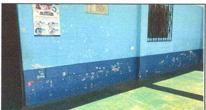
PINTURA EN MUROS EXTERIORES E INTERIORES
