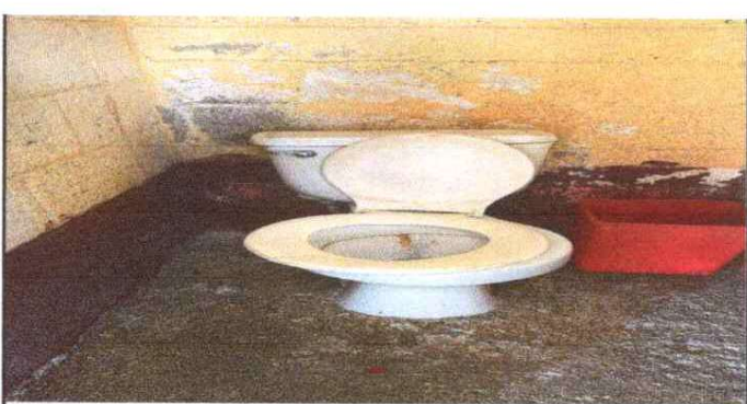
SUSTITUCIÓN DE SANITARIOS
