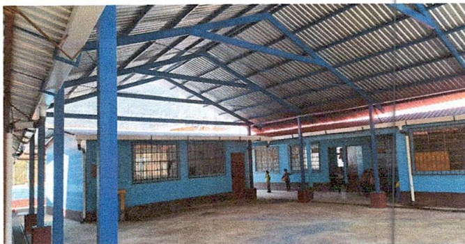
Foto 3: Sustitución de estructura de soporte de metal por metal
