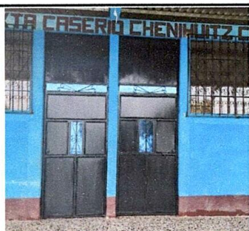
FOTO 11: Sustrucción de puerta
