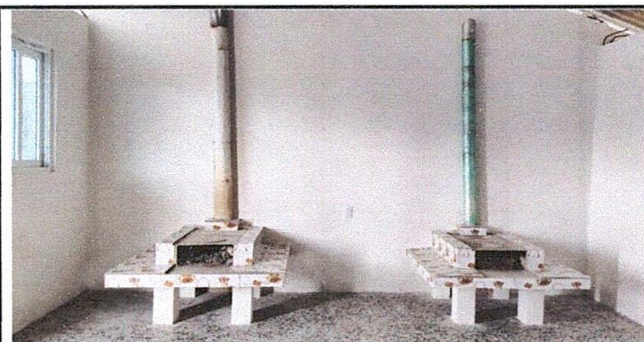
FOTO 4: Instalación de azulejo en estufa rural
