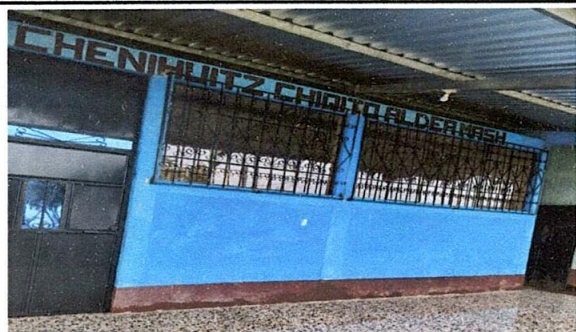
FOTO 9: Sustrucción de balcones de metal
