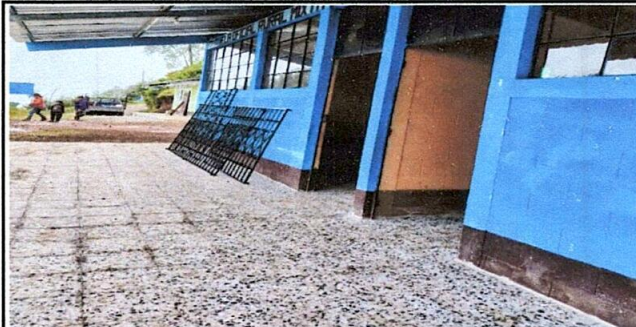
FOTO 8: Sustrucción de piso de granito
