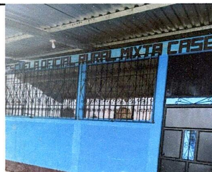
FOTO 10: Sustrucción de balcones de metal
