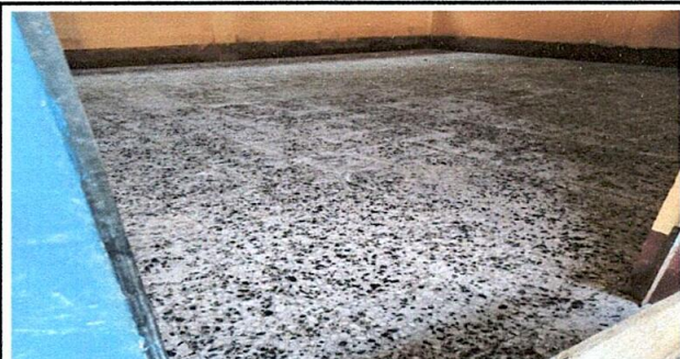
FOTO 7: Sustrucción de piso de granito
