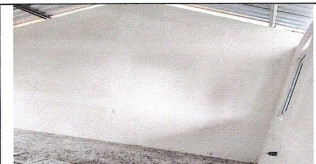
FOTO 5: Repello en paredes
