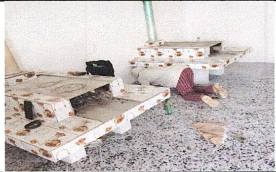
FOTO 4: Instalación de azulejo en estufa rural
