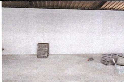
FOTO 6: Repello en paredes
