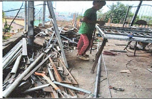
FOTO 12: Sustrucción de puerta
