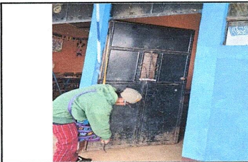
FOTO 11: Sustrucción de puerta
