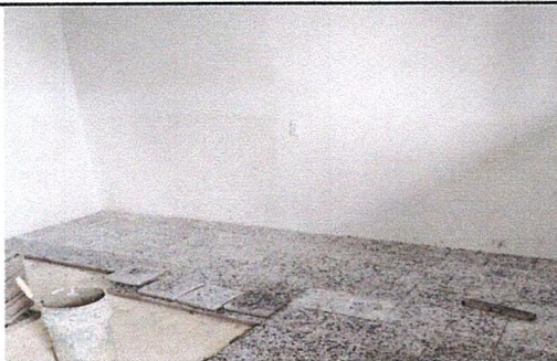
FOTO 5: Repello en paredes
