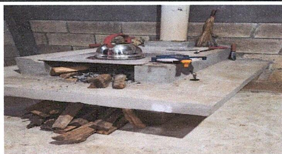
FOTO 2: Instalación de azulejo en estufa rural
