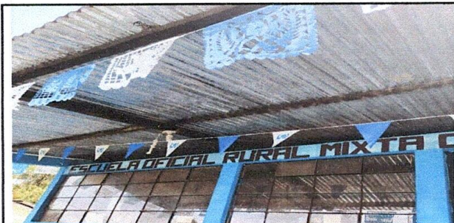
FOTO 5: Sustrucción de balcones de metal
