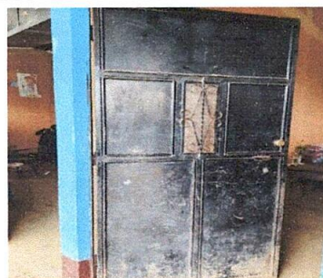
FOTO 6: Sustrucción de puerta
