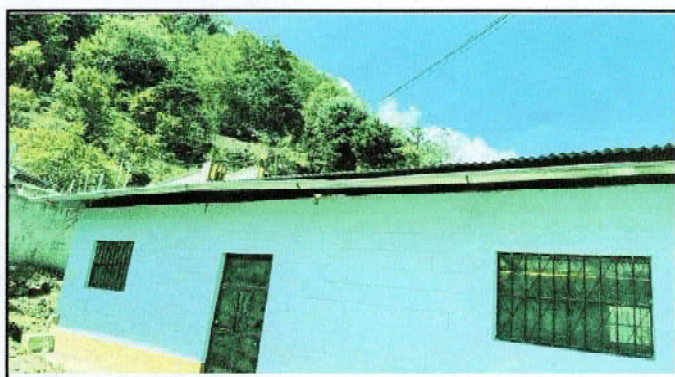
FOTO 4: PINTURA EN MUROS EXTERIORES E INTERIORES
