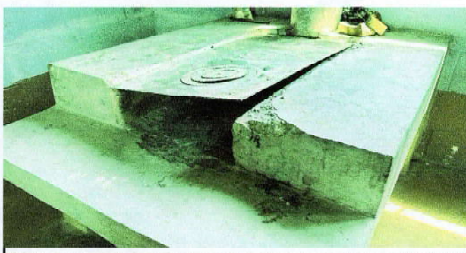
FOTO 6: SUSTITUCION DE PLANCHA DE METAL
