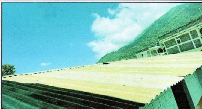
FOTO 1: SUSTITUCION DE LAMINA
