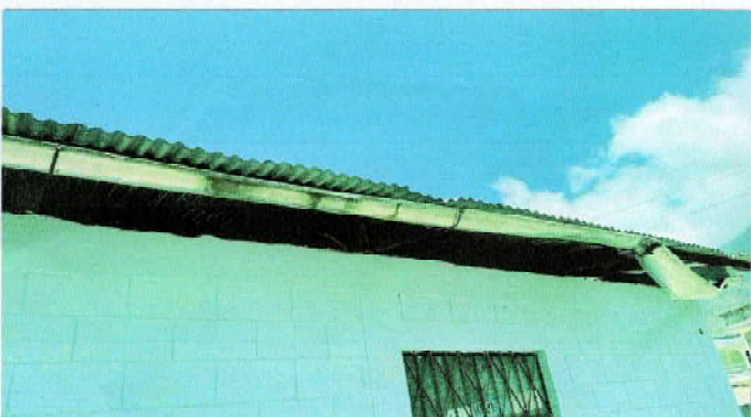
FOTO 3: SUSTITUCION DE CANAL
