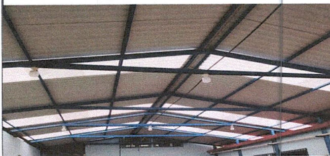
Foto 5: REPARACIÓN DE SISTEMA ELECTRICO
