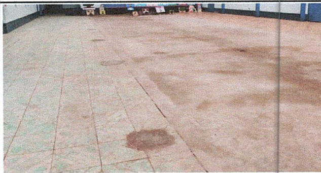
Foto 3: Sustitución de piso de torta de concreto
