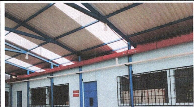
Foto 4: CANALES Y BAJADAS DE AGUA PLUVIALES
