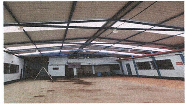
Foto 2: ESTRUCTURA DE TECHO Y CUBIERTA DE LAMINA
