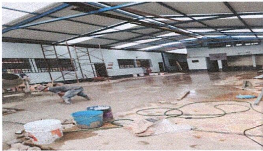
Foto 3: Sustitución de piso de torta de concreto
