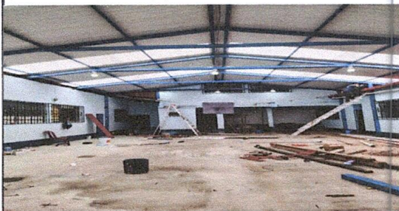
Foto 5: REPARACIÓN DE SISTEMA ELECTRICO
