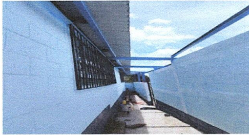
Foto 1: Mantenimiento de estructura portante de metal
