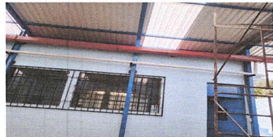
Foto 4: CANALES Y BAJADAS DE AGUA PLUVIALES
