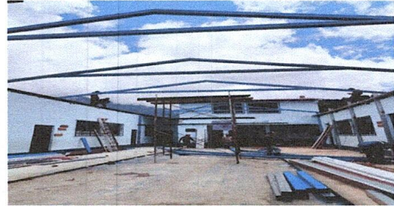
Foto 2: ESTRUCTURA DE TECHO Y CUBIERTA DE LAMINA
