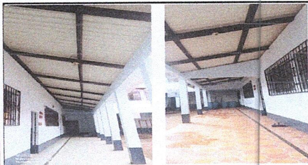
Foto 5: REPARACIÓN DE SISTEMA ELECTRICO
