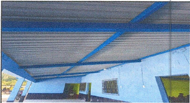
Foto 3: Cambio de estructura de madera a metal
