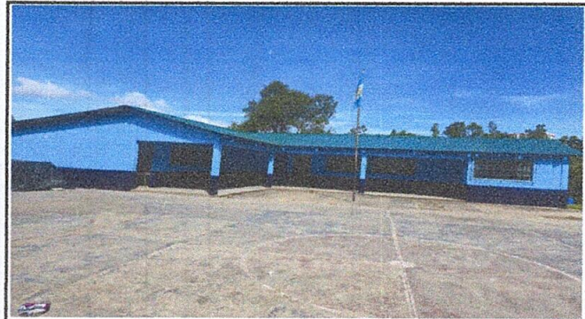
Foto 2: Cambio de techo de lamina troquelada
