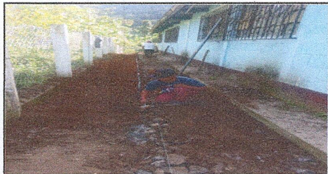
Foto 6: Reparación de cuneta
