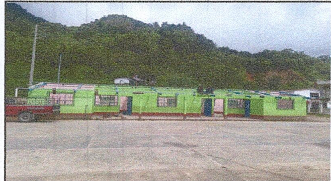
Foto 2: Cambio de techo de lamina troquelada
