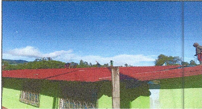
Foto 1: Cambio de techo lamina troquelada
