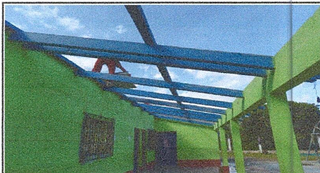
Foto 3: Cambio de estructura de madera a metal
