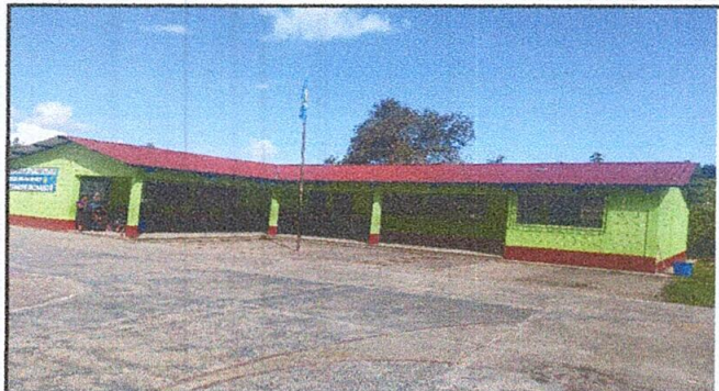
Foto 2: Cambio de techo de lámina troquelada
