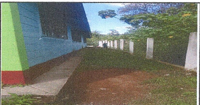
Foto 6: Reparación de cuneta
