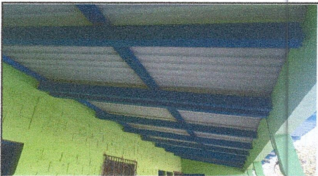
Foto 3: Cambio de estructura de madera a metal
