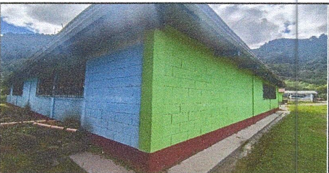
Foto 5: Pintado de escuela interior y exterior
