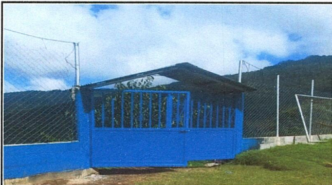
FOTO 1: SUSTITUCIÓN DE PORTON DE METAL
