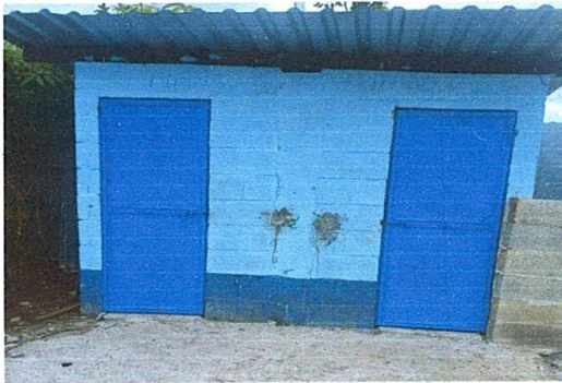
FOTO 15: SUSTITUCIÓN DE PUERTAS EN SERVICIOS SANITARIOS
