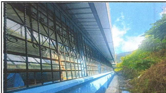
FOTO 4: SUSTITUCIÓN DE BALCONES DE METAL
