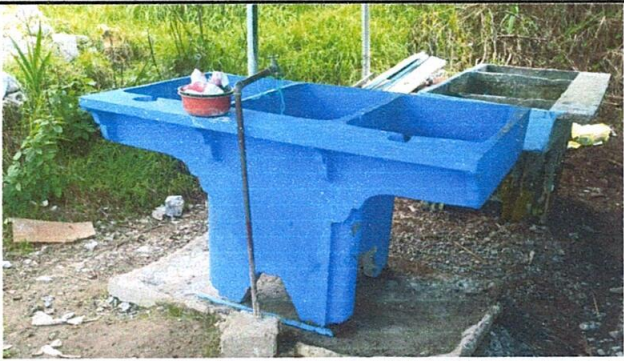
FOTO 13: Sustrucción de deposito de agua 2500 lt (PILAS PLASTICA Y DE CONCRETO)
