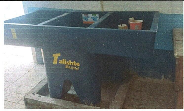
FOTO 14: Sustrucción de deposito de agua 2500 lt (PILAS PLASTICA Y DE CONCRETO)
