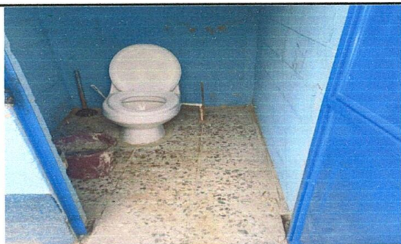
FOTO 9: SUSTITUCIÓN DE INODORO Y LAVAMANOS
