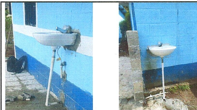
FOTO 8: SUSTITUCIÓN DE INODORO Y LAVAMANOS
