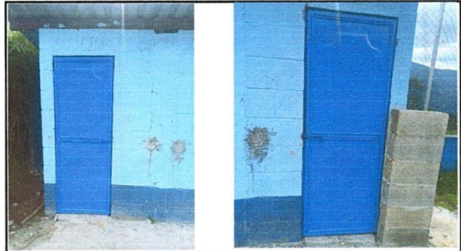
FOTO 16: SUSTITUCIÓN DE PUERTAS EN SERVICIOS SANITARIOS
