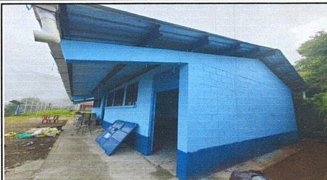
FOTO 7: PINTURA EN MUROS EXTERIORES E INTERIORES
