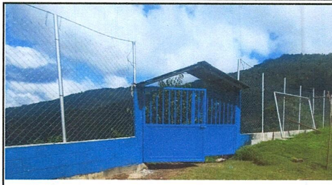
FOTO 2: SUSTITUCIÓN DE PORTON DE METAL
