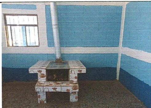
FOTO 11: INSTALACIÓN DE AZULEJO EN ESTUFA RURAL
