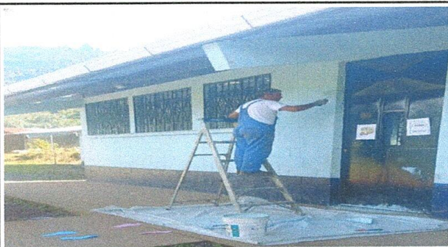
FOTO 7: PINTURA EN MUROS EXTERIORES E INTERIORES
