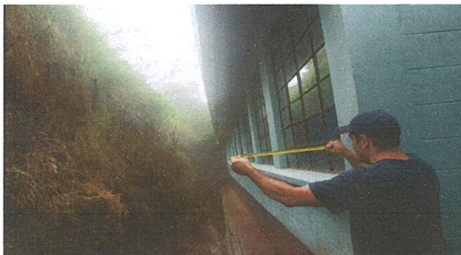
FOTO 3: SUSTITUCIÓN DE BALCONES DE METAL
