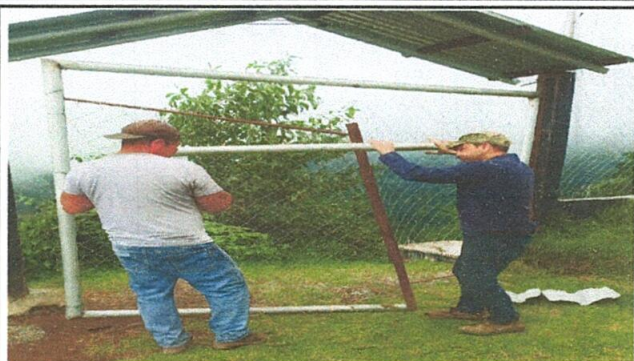
FOTO 2: SUSTITUCIÓN DE PORTON DE METAL
