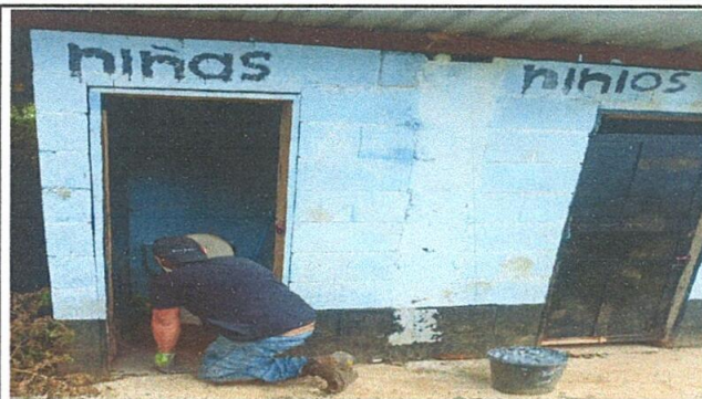
FOTO 1: SUSTITUCIÓN DE PUERTAS EN SERVICIOS SANITARIOS
