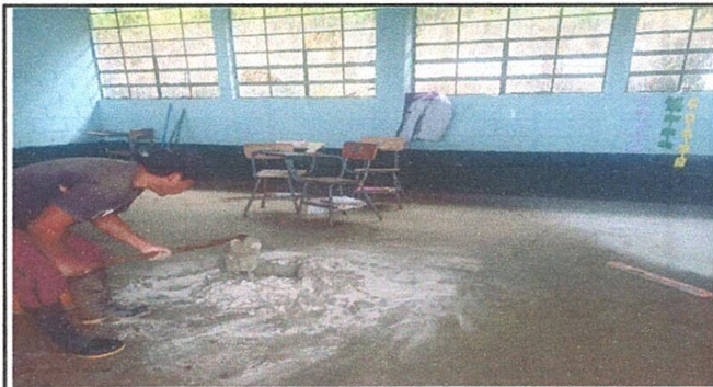
FOTO 6: SUSTITUCIÓN DE TORTA DE CONCRETO A PISO GRANITO
