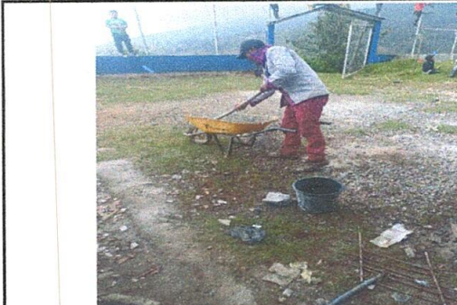
FOTO 12: REPELLO EN MURO
