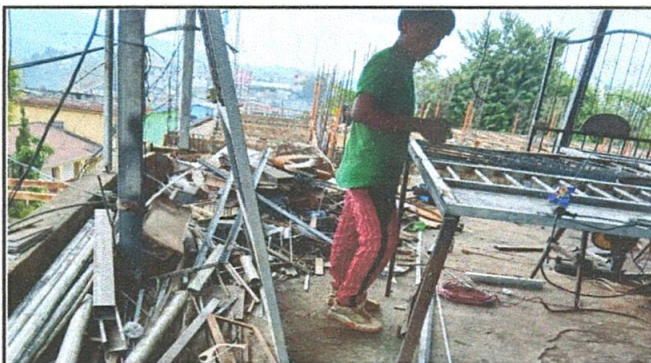
FOTO 4: SUSTITUCIÓN DE BALCONES DE METAL
