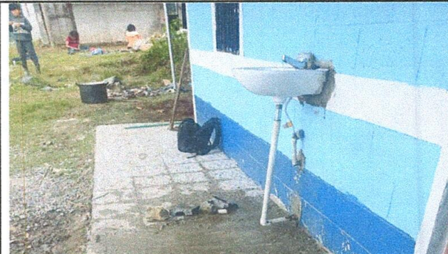
FOTO 8: SUSTITUCIÓN DE INODORO Y LAVAMANOS
