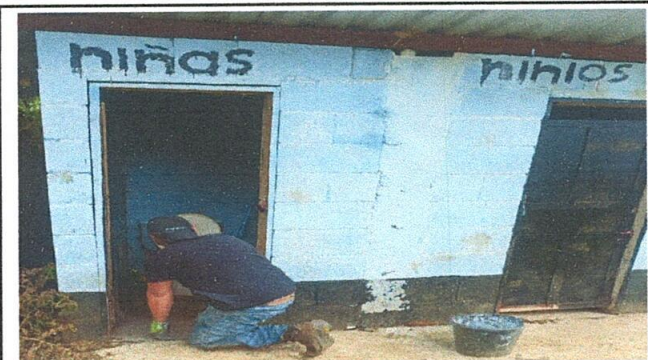
FOTO 9: SUSTITUCIÓN DE INODORO Y LAVAMANOS
