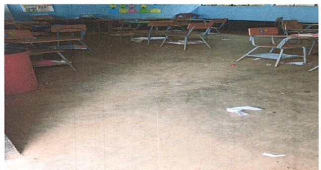
FOTO 4: SUSTITUCIÓN DE TORTA DE CONCRETO A PISO GRANITO
