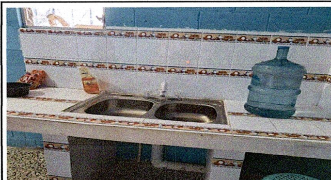
FOTO 4: Mejoramiento de cocina
