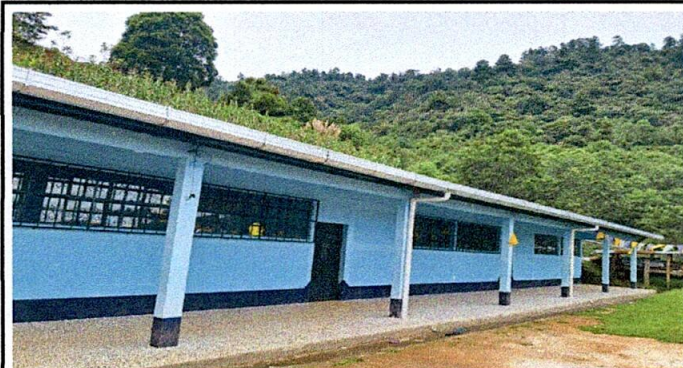
FOTO 2: Sustrucción de canal de pvc
