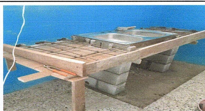
FOTO 4: Mejoramiento de cocina
