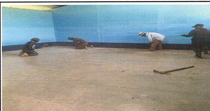
FOTO 3: Sustrucción de piso
