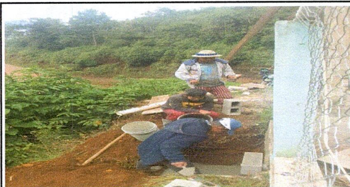
FOTO 5: Reparación de red de drenaje
