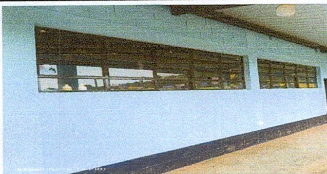
Foto 5: Mejoramiento de balcones de metal
