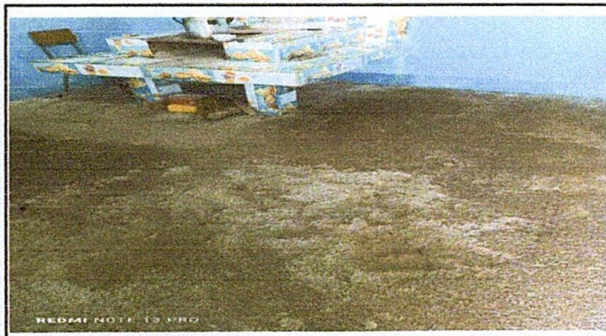
Foto2: Sustrucción de piso por piso granito
