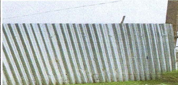
Foto 4: Sustrucción de portón de metal
