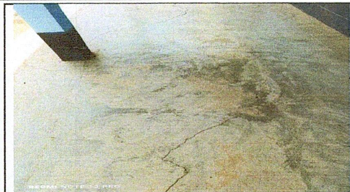
Foto1: Sustrucción de piso por piso granito
