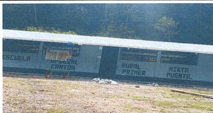
SUSTITUCION DE LAMINA
