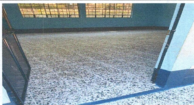
SUSTITUCIÓN DE PISO GRANITO
