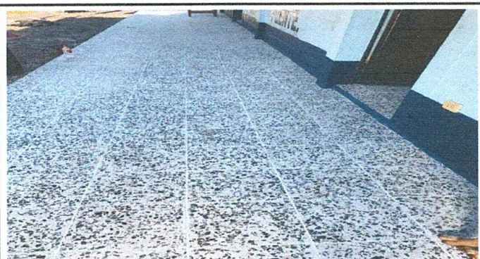
SUSTITUCION DE PISO GRANITO
