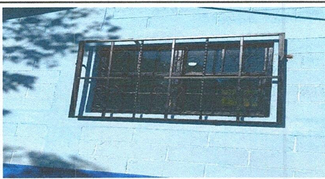
SUSTITUCIÓN DE BALCON
