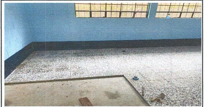
SUSTITUCIÓN DE PISO GRANITO
