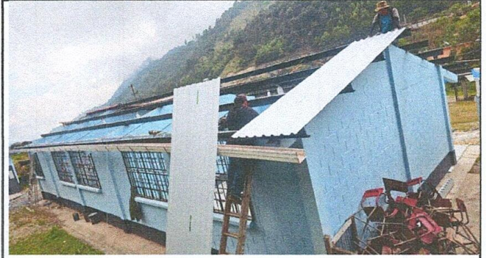
SUSTITUCIÓN DE LAMINA
