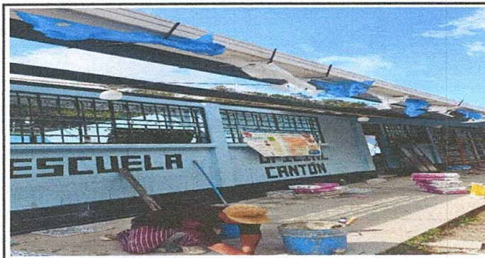
SUSTITUCIÓN DE CANAL
