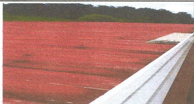
FOTO 1: Sustrucción de lámina por lámina troquelada
