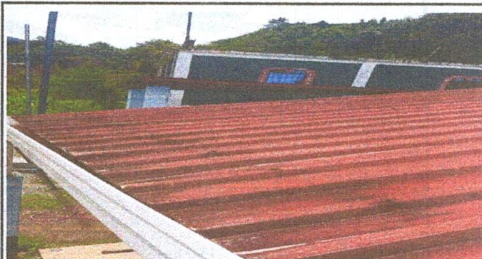
FOTO 2: Sustrucción de lámina por lámina troquelada y mantenimiento a estructura
