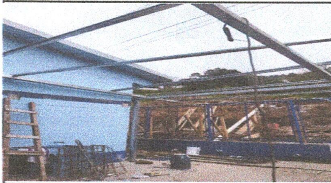
SUSTITUCIÓN DE LAMINA
