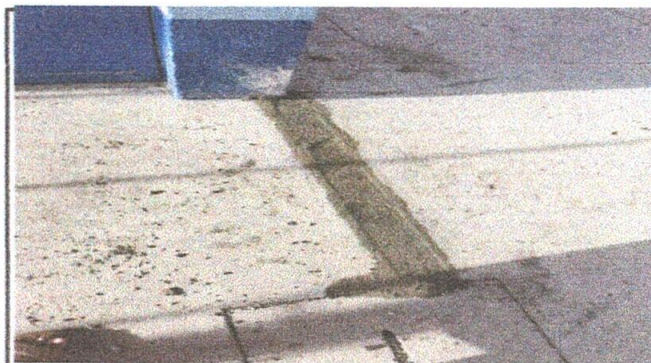
REPARACIÓN DE LOZA DE PATIO
