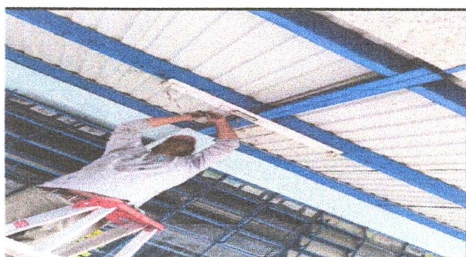
SUSTITUCIÓN DE SISTEMA ELECTRICO
