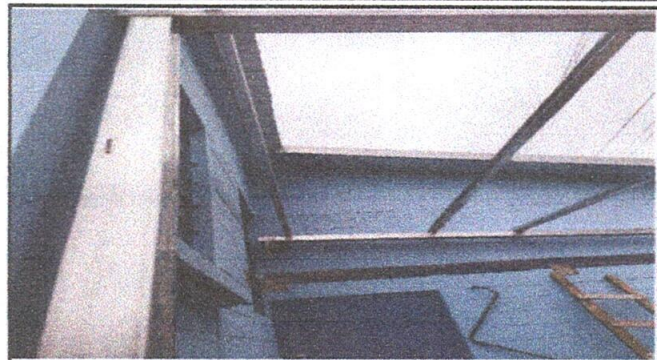
SUSTITUCIÓN DE ELEMENTOS DE FIJACION
