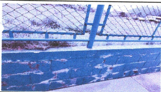
FOTO 3: Impermeabilización de muros
