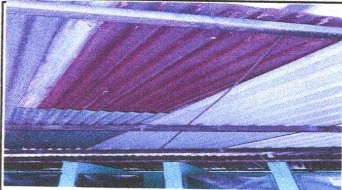
FOTO 1: Sustrucción de estructura de techo
