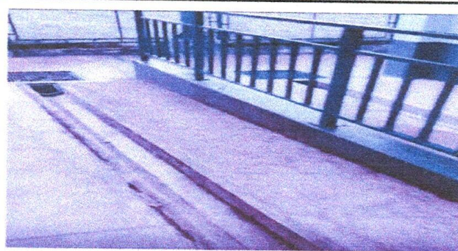
FOTO 4: Mantenimiento a barandas
