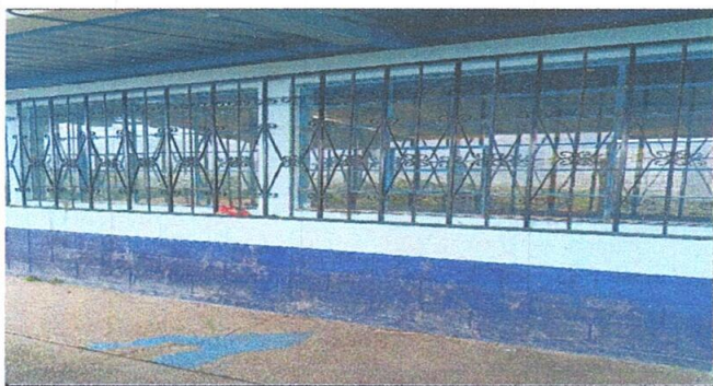
FOTO 5. MANTENIMIENTO DE BALCONES EN VENTANAS
