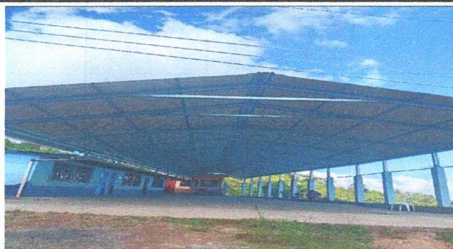
FOTO 1: REPARACION DE y SUSTITUCION DE TECHO EN EL PATIO DE EDIFICIO ESCOLAR
