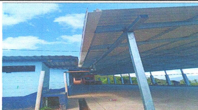
Foto 2: SUSTITUCIÓN DE CANALES Y BAJADA DE AGUA PLUVIAL
