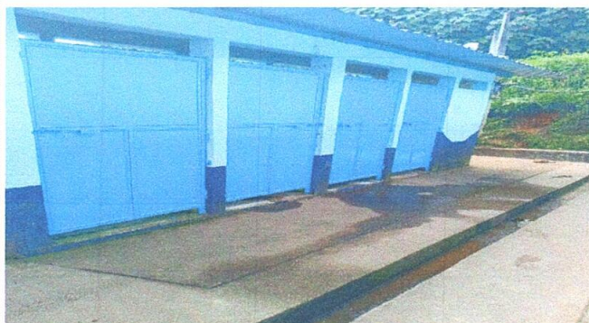
FOTO 3: MANTENIMIENTO A PUERTAS DE SANITARIOS
