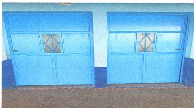
FOTO 4: MANTENIMIENTO A PUERTAS DE AULAS
