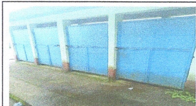
FOTO 3: MANTENIMIENTO A PUERTAS DE SANITARIOS
