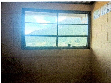
Foto 9: Sustrucción de vidrios para ventanas de 31.5*86.5 centímetros
