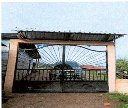
Foto 3: Sustrucción de estructura de techo para portón
