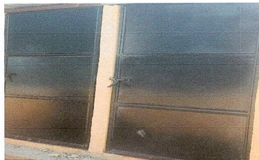
Foto 6: Sustrucción de puerta 1.95 metros de alto por 1.01 metro de ancho
