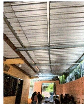
Foto 2: Sustrucción de lámina, por lámina troquelada aluzinc calibre 26
