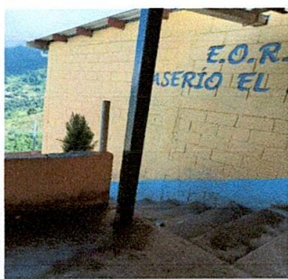
Foto 1: Sustrucción de estructura de soporte de madera por metal
