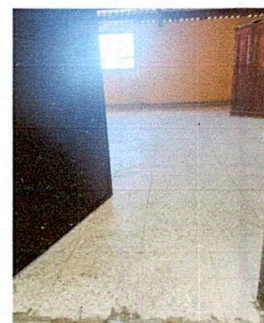
Foto 10: Sustrucción de piso de torta de cemento por piso granito
