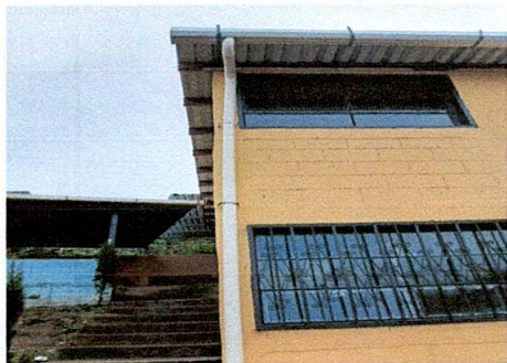
Foto 11: Sustrucción de canales de metal y bajadas de agua pluvial tubería PVC 3"
