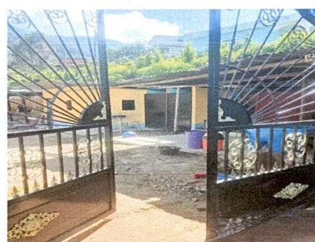
Foto 4: Sustrucción de porton de 3 metros de ancho por 2.42 metros de alto
