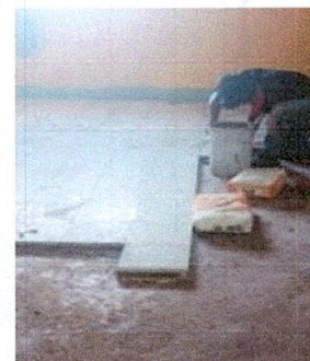
Foto 10: Sustrucción de piso de torta de cemento por piso granito
