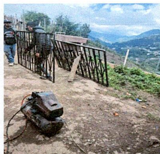
Foto 8: Mantenimiento de estructura de metal de ventanas de 1.88 metro de alto por 1.08 de largo
