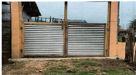
Foto 4: Sustitucion de porton de 3 metros de ancho por 2.42 metros de alto
