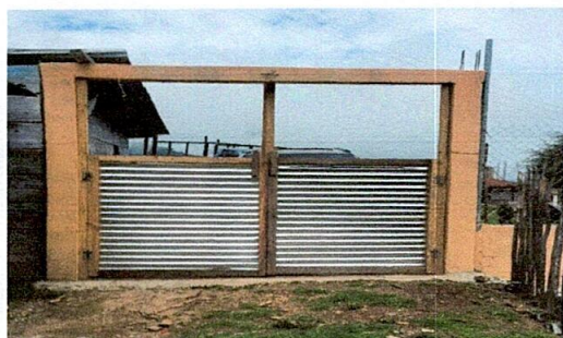
Foto 3: Sustitucion de estructura de techo para portón
