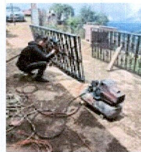
Foto 8: Mantenimiento de estructura de metal de ventanas de 1.88 metro de alto por 1.08 de largo
