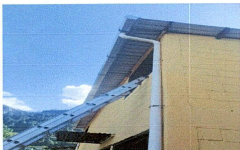
Foto 11: Sustrucción de canales de metal y bajadas de agua pluvial tubería PVC 3"
