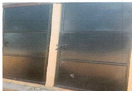
Foto 6: Sustitución de puerta 1.95 metros de alto por 1.01 metro de ancho
