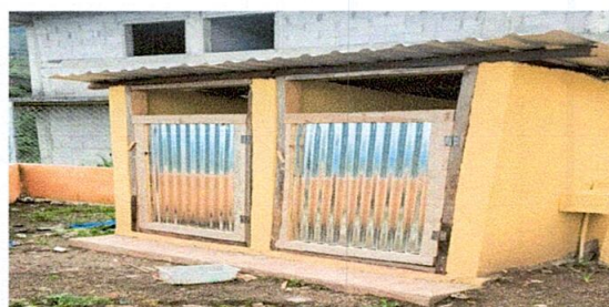
Foto 6: Sustitución de puerta 1.95 metros de alto por 1.01 metro de ancho
