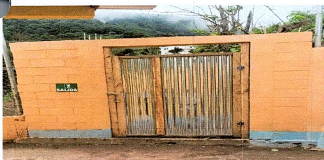
Foto 5: Portón de metal de 1.50 metros de ancho por 2.26 metros de alto.
