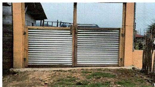
Foto 4: Sustitucion de porton de 3 metros de ancho por 2.42 metros de alto
