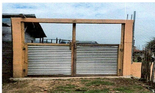
Foto 3: Sustitucion de estructura de techo para portón
