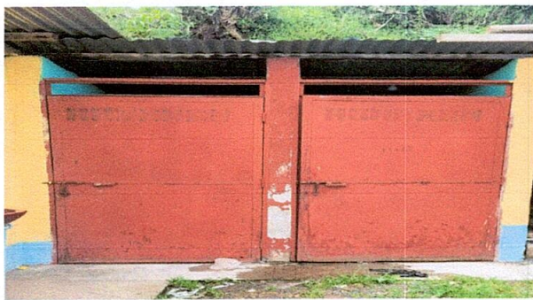
Foto7: Sustrución de puerta 2 metros de alto por 1.01 metro de ancho
