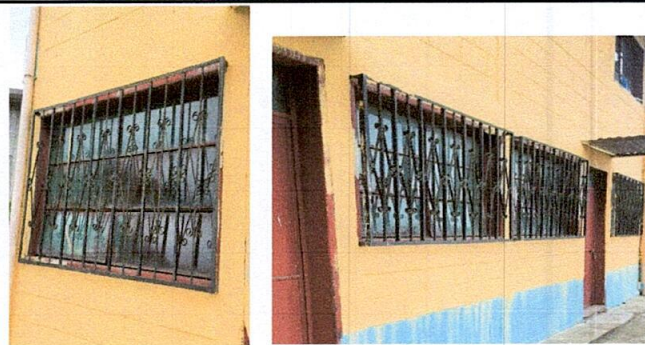
Foto 8: Mantenimiento de estructura de metal de ventanas de 1.88 metro de alto por 1.08 de largo
