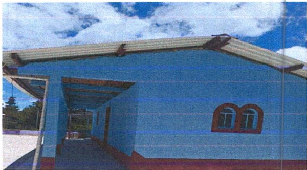
FOTO 1: Sustrucción de lámina y estructura
