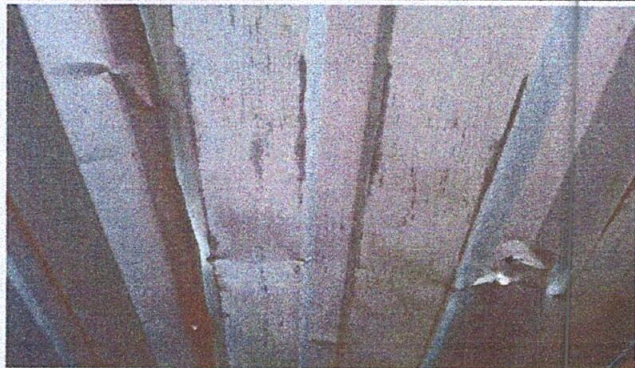
FOTO 1: Sustitución de lámina y estructura
