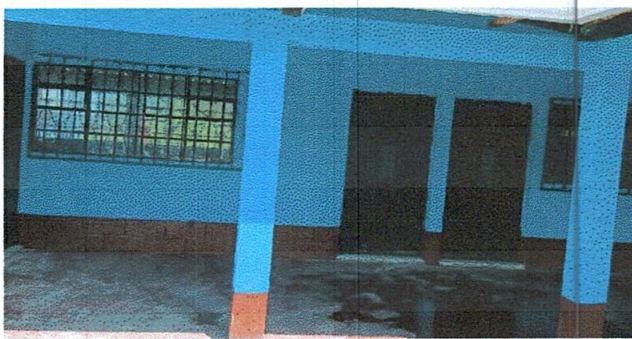
Foto 3: Pintura de muros exteriores e interiores
