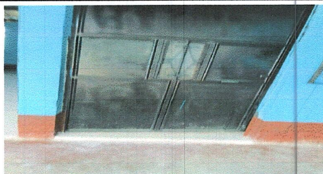
Foto 5: Mantenimiento a estructura de puertas de metal
