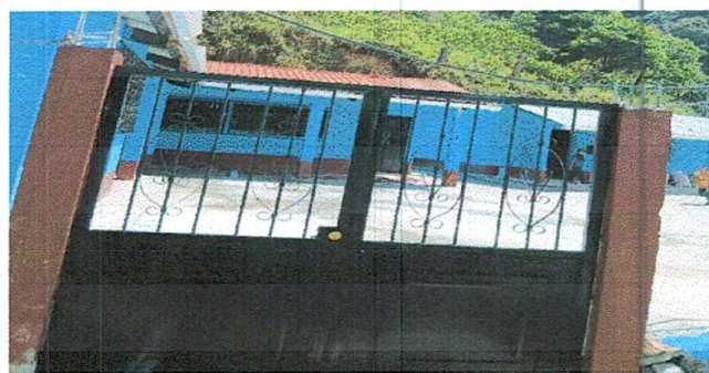
Foto 3: Mejoramiento de porton de metal de 2 metros de ancho por 2 metros de alto
