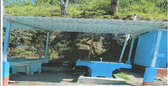
Foto 2: Sustrucción de pila de cemento de dos lavaderos
