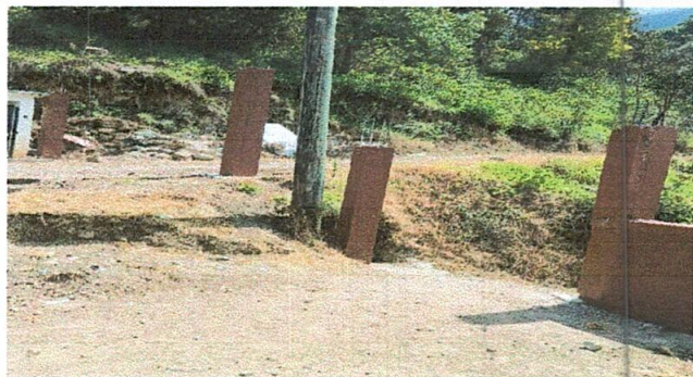
Foto 3: Mejoramiento de porton de metal de 2 metros de ancho por 2 metros de alto
