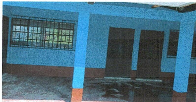
Foto 3: Pintura de muros exteriores e interiores
